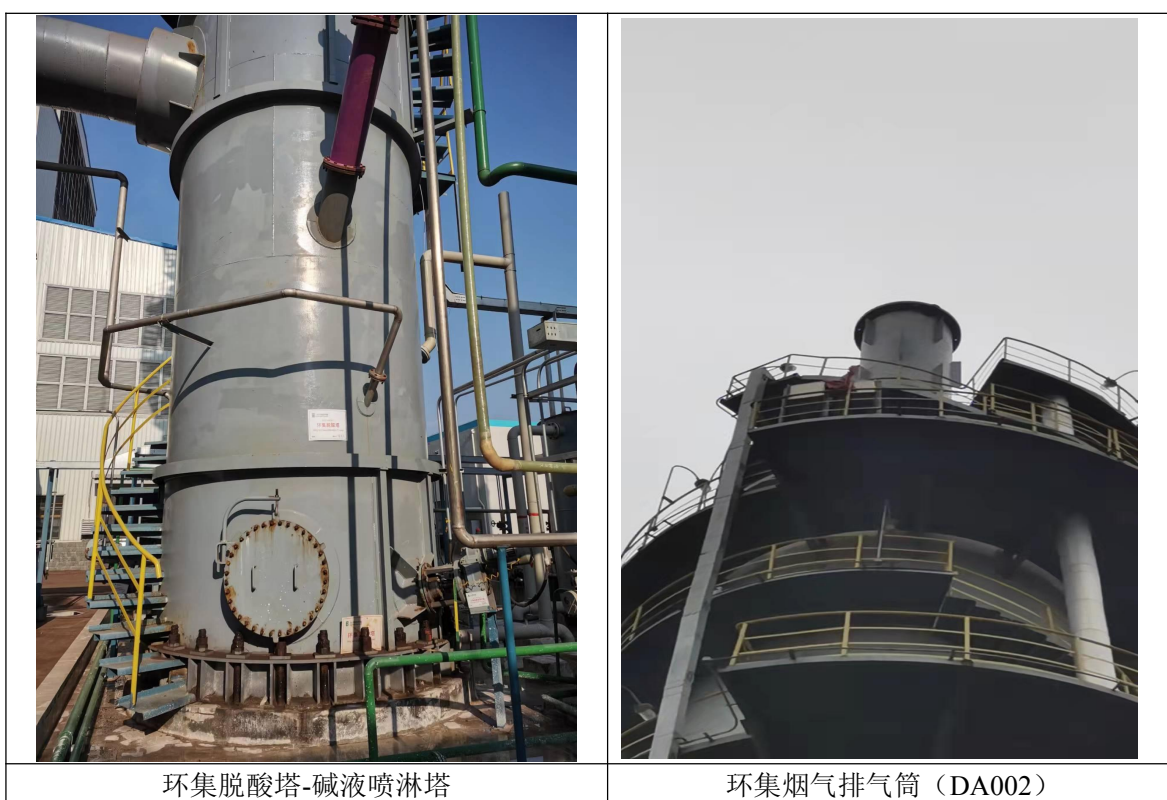
图 4.1-6 合金炉烟气处理设施
