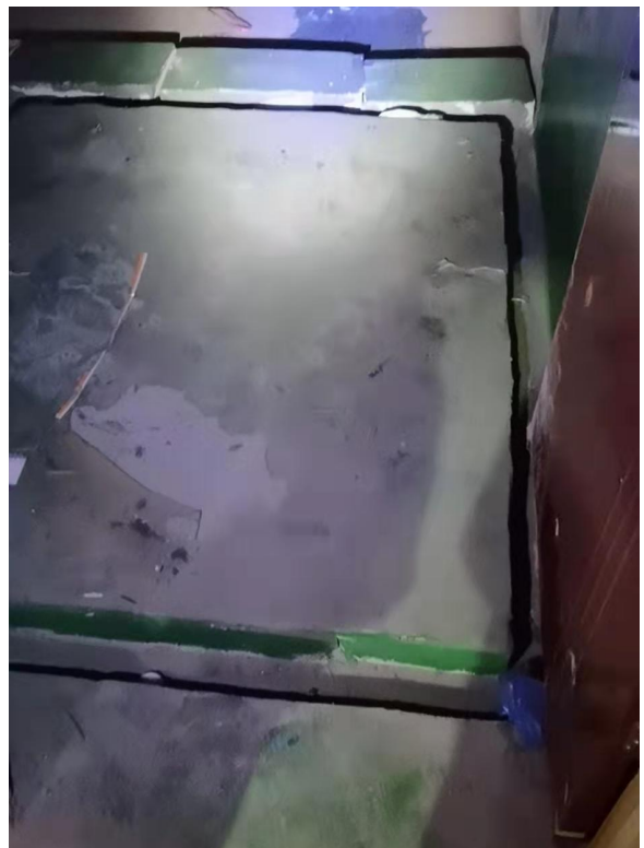
危险废物暂存库
