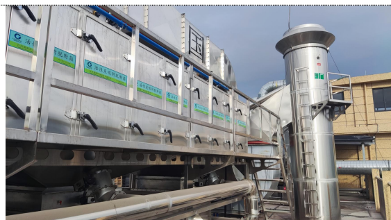
水喷淋+活性炭吸附+脱附+催化燃烧（油漆废气处理设施）
