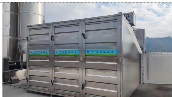
水喷淋+活性炭吸附+脱附+催化燃烧（油漆废气处理设施）
