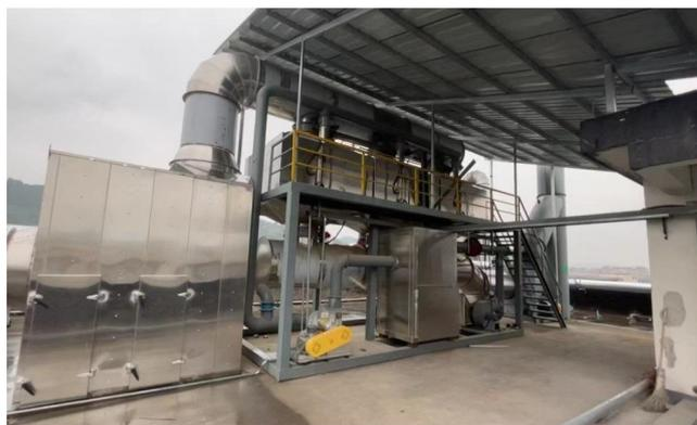
油漆废气处理设施（水喷淋+干式过滤+活性炭吸附+催化燃烧）
